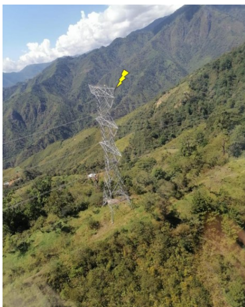
Gráfico No. 14 Punto de falla estructura 256.
